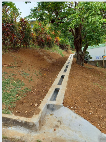
La Trinité - Terrassement et reprise des réseaux EP
