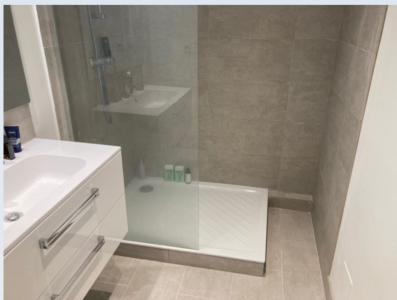
Menton – Rénovation de 4 salles de bain
