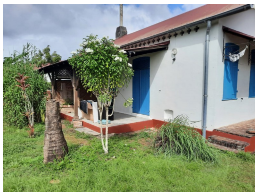
Travaux de rénovation Villa Saint Laurent du Maroni
