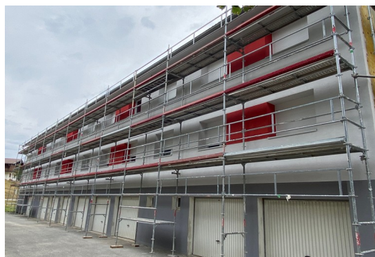
Travaux d'isolation thermique par l'extérieur Les Rousses
