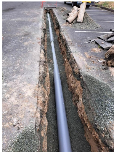
Réfection réseaux eaux pluviales La Rochelle
