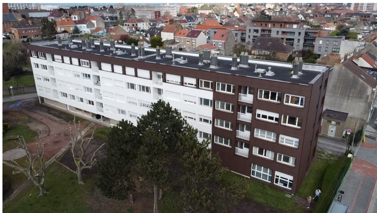
Réhabilitation des extérieurs de la cité Rosendaël
