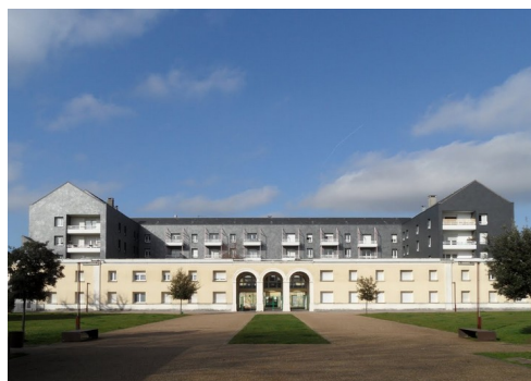
Cité des douanes du Havre
